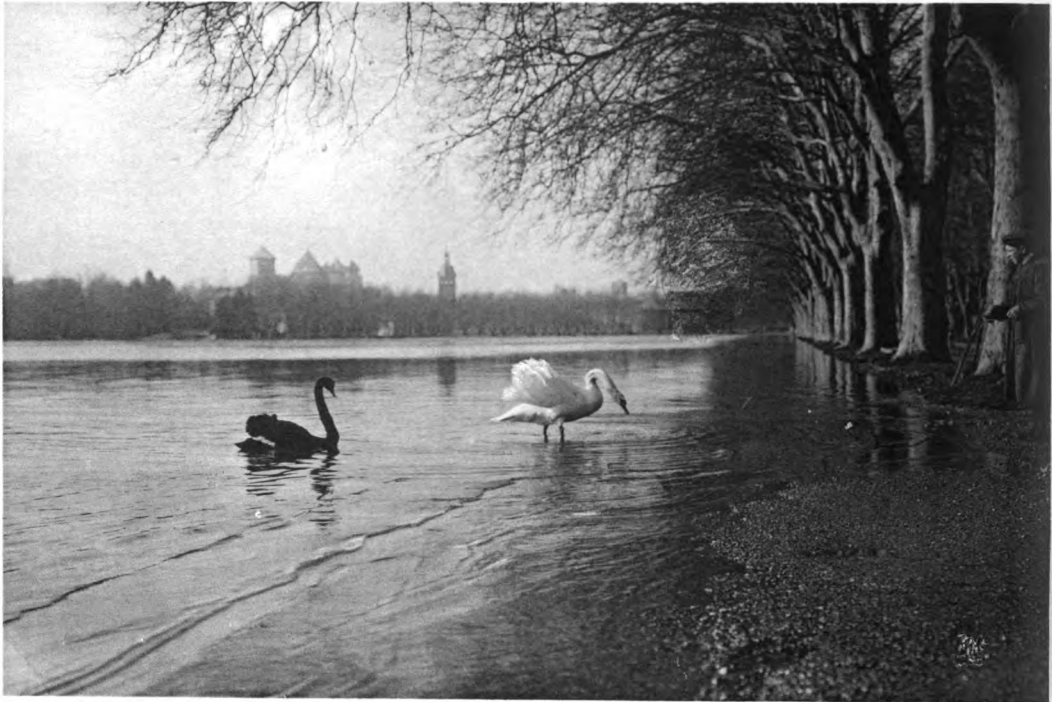
CRUE DU 21 JANVIER 1910
